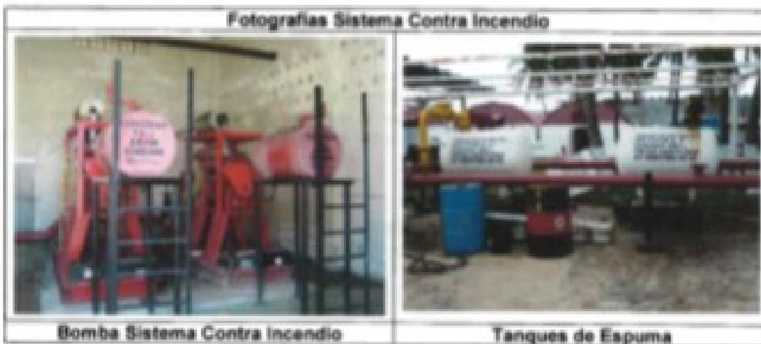
**Figura 5. Equipos que componen el Sistema Contra Incendio de la Terminal**
